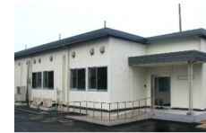
2007(平成19)年 高機能開発支援棟新設 (食品開発研究所)
