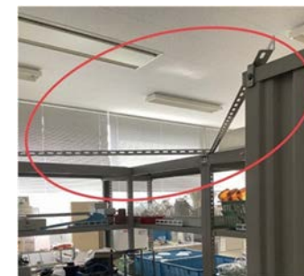
指摘事項に対する改善事例(左図:棚の転倒防止金具、右図:階段手すり)
