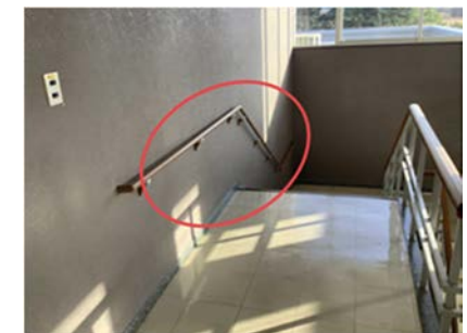
指摘事項に対する改善事例(左図:棚の転倒防止金具、右図:階段手すり)
