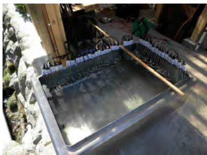
図5 温水ヒータおよび温水槽
