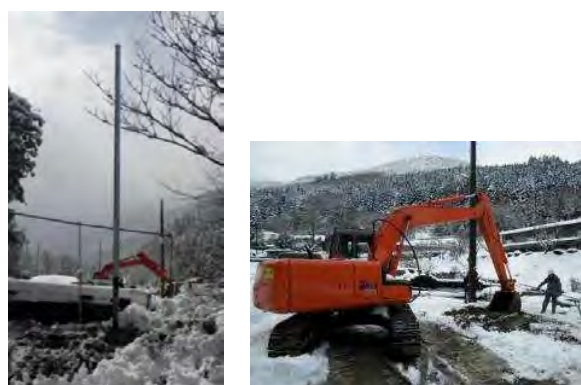
図3 設置した鋼管柱（左図）および設置作業の様子（右図）
