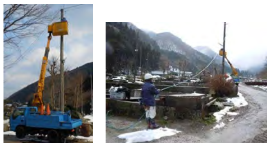
図2 送電線の設置作業の様子
